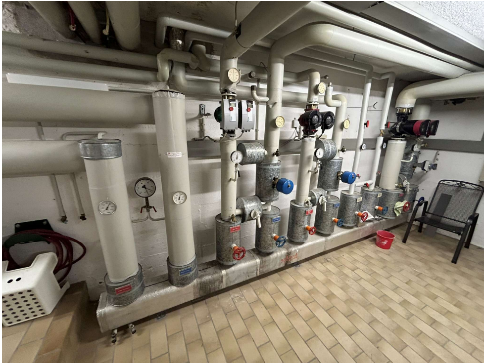
Abbildung 38: Heizungsunterstation (Gebäude Sieben Eichen Mittelbau)
