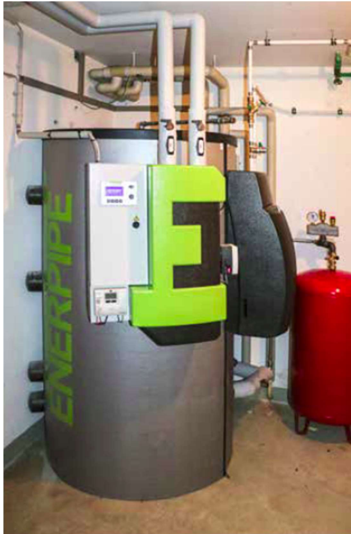
Abbildung 39: Übergabestation und Frischwasserstation [13]
