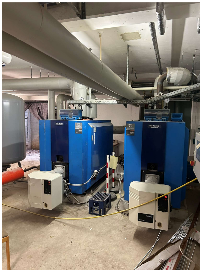
Abbildung 4: Heizölkessel des Gebäudenetzes
